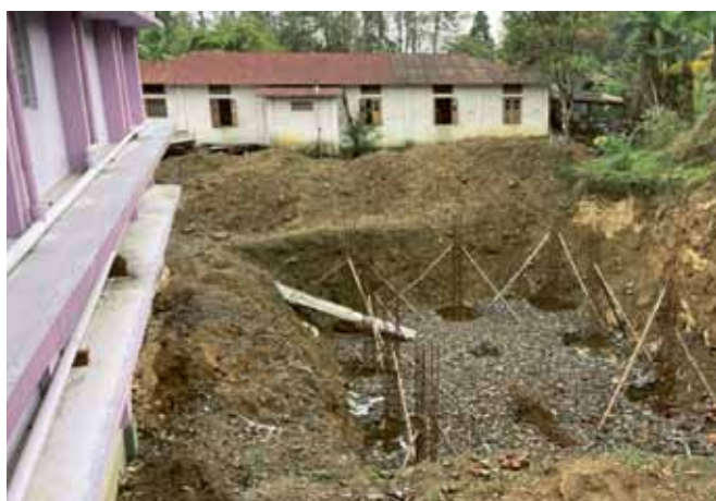
Nach Fertigstellung des Wassertanks kann das Projekt erfolgreich abgeschlossen und mit dem Folgeprojekt – dem Bau der sanitären Anlagen – begonnen werden.
