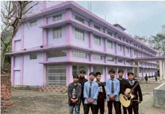
Das Hostel für 123 Jungen ist bereits fertiggestellt.
